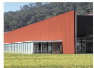
本館西側とプラザの壁は赤茶色。この壁は、コルテン鋼という表面を錆びさせた鋼板です(表面の錆が内部への腐食を防ぐ特殊な鋼板)。
