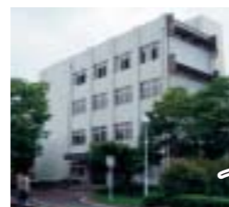
教養講義棟2号館
