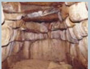
すべての壁が小さめの石を積んで、傾けながら造られた例。(鶏ノ鼻古墳群:益田市遠田)
