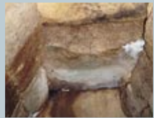
天井石にもいろいろの例があり、チェックポイント。(放れ山古墳)
