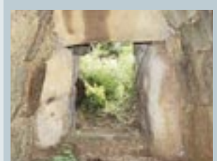
両側に立った石が袖石。片方だけのものや、まったくないものもある。 (放れ山古墳:出雲市古志町)
