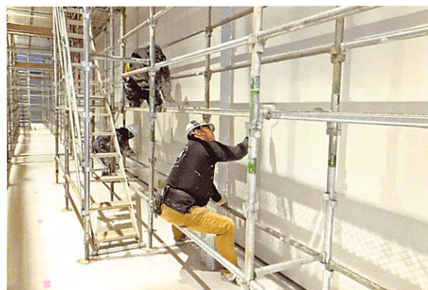
特別展示室 可動壁の再塗装の様子
