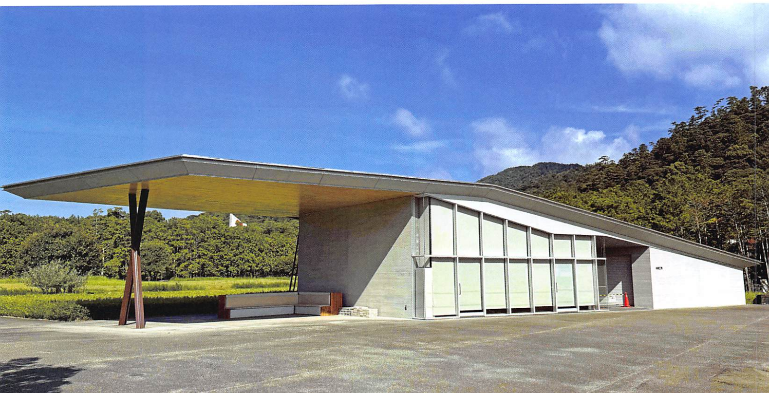
体験工房(竣工時)
